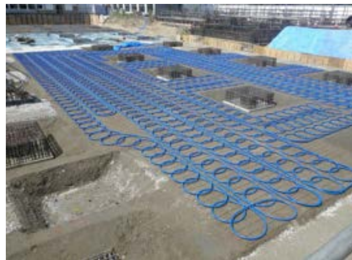
水平ループ方式（スリンキー式）
