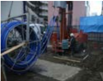
Uチューブ挿入状況
