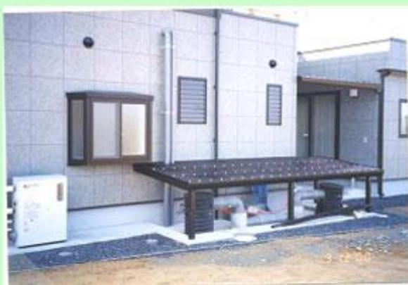
図3 GEOパワーシステムの地表部の外観
